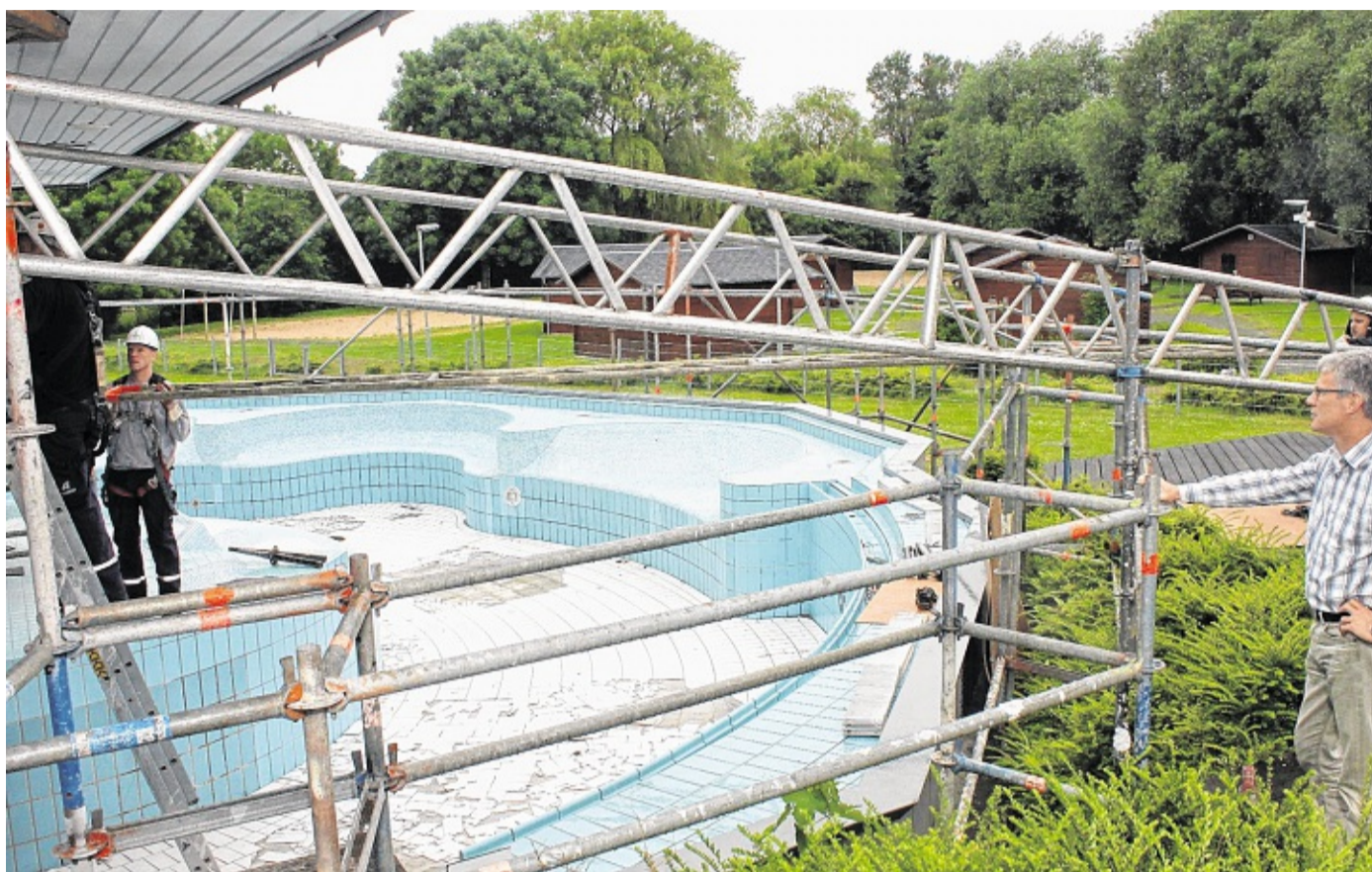
Gerüstbau über dem Außenbecken: Guido Austen (r.), Prokurist der Freizeitbad Brunsbüttel GmbH, verfolgt den Start der Sanierungsarbeiten. sh:z
