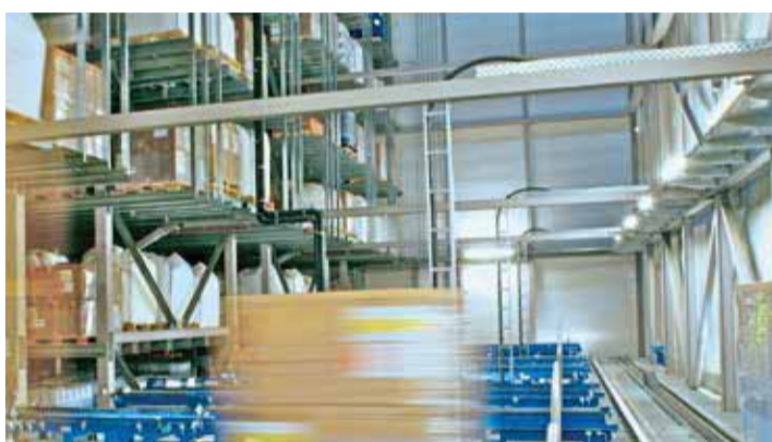
Das vollautomatische Hochregallager bietet über 37.000 Stellplätze.
