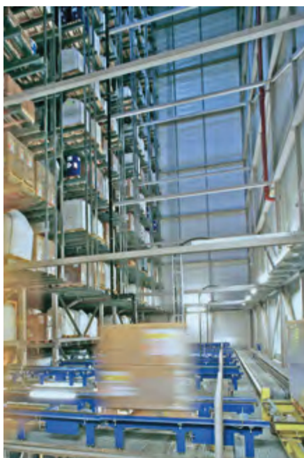
Ein Hochregallager in Brunsbüttel
